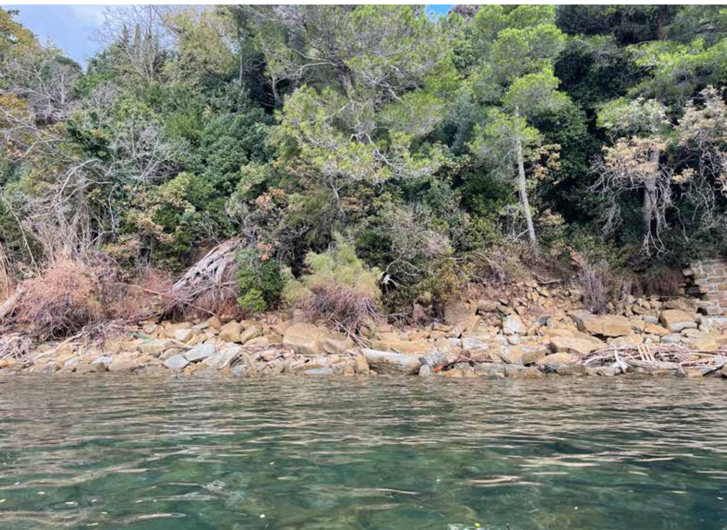
Piccola frane a ridosso della riva sul litorale a nord di Grignano. Pur essendo protetto da muretti di sostegno in arenaria, in alcuni punti i versanti cedono riversando il materiale sulle spiagge sottostanti.
