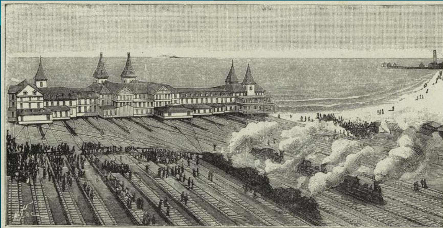
Il Brighton Hotel a Coney Island nello Stato di New York fu arretrato di oltre 150 metri nel 1888. Furono usate 120 pedane di carri ferroviari e 6 locomotive per muovere tutta la struttura del peso di 6000 tonnellate. L'impresa durò circa 3 mesi e nello spostamento non si ruppe neanche un vetro.
