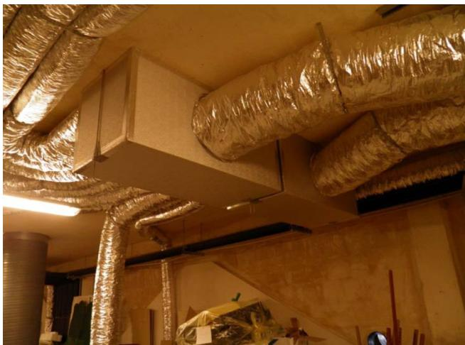
Struttura di nuova realizzazione con intercapedine aerata e impianto di ricambio d'aria
