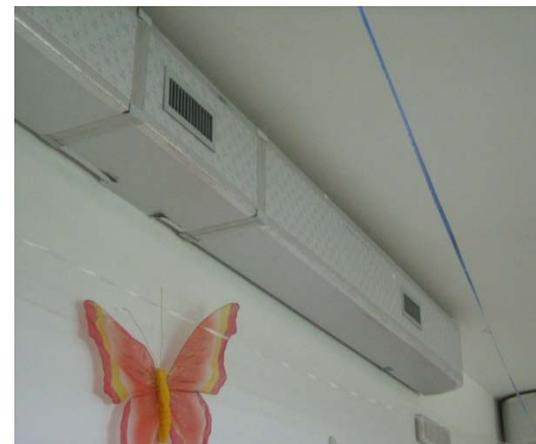
Ricambio d'aria con scambio di calore
